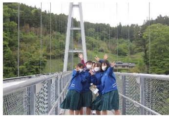
九重夢大吊橋
